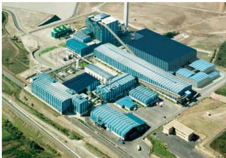
Vista aérea del complejo medioambiental de Sogama en Cerceda
