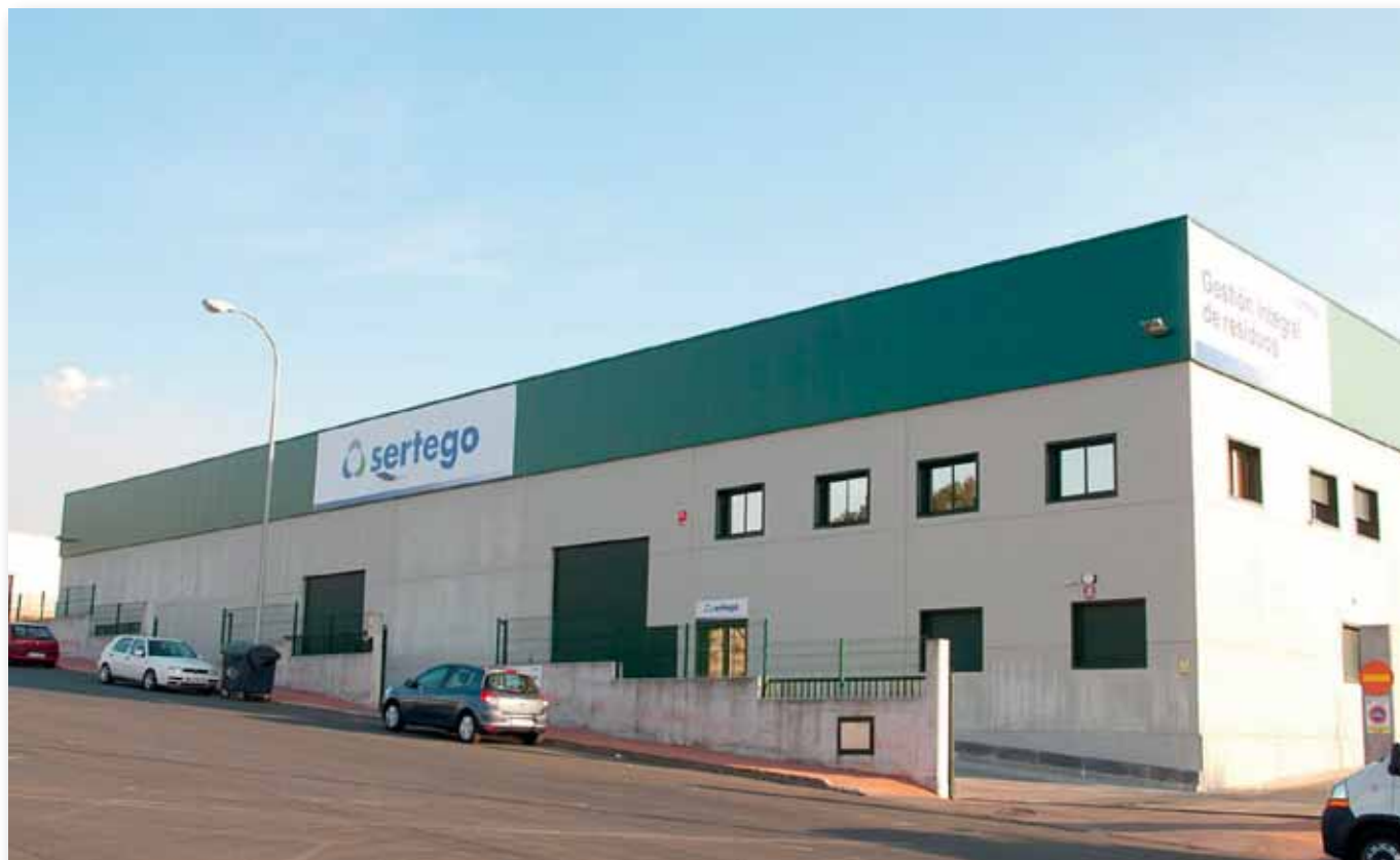
Foto.1. Instalaciones Sertego sitas en Lalín, Pontevedra.
