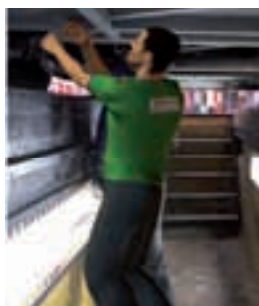
Imágenes: Trabajos en el interior del foso.
